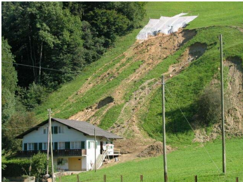
Abb. 12: Hangrutsche oberhalb Sunnärain, Ennetmoos
