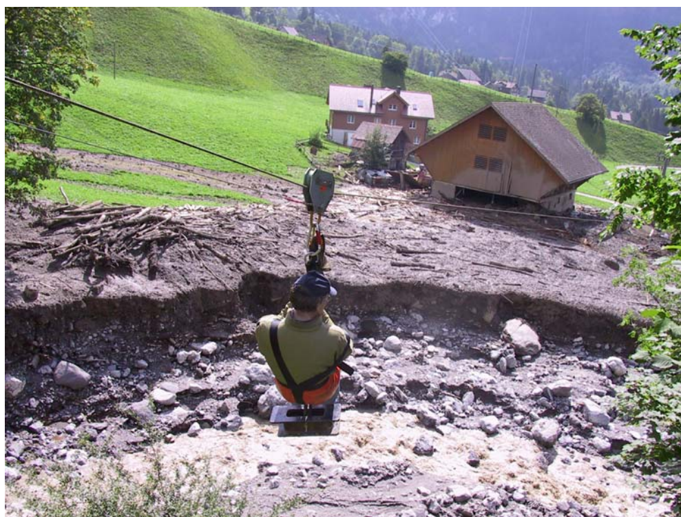
Abb. 9: Schäden des Haldibachs in Oberrickenbach
