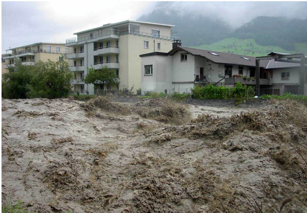
Abb. 7: Aa in Buochs. Das Bild vom 23. August 2005 zeigt deutlich, dass die Entlastungen oberhalb von Buochs unentbehrlich sind. Denn ohne die Entlastung von 60 m 3 /s oberhalb von Buochs wären hier über 200 m 3 /s statt den im Bild zu sehenden knapp 150 m 3 /s abgeflossen, was mit Sicherheit zu Dammbrüchen geführt hätte.
